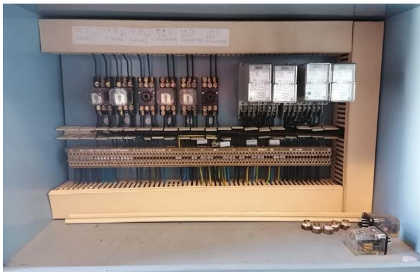
Slika 1. Relejna izvedba sustava za gašenje požara
